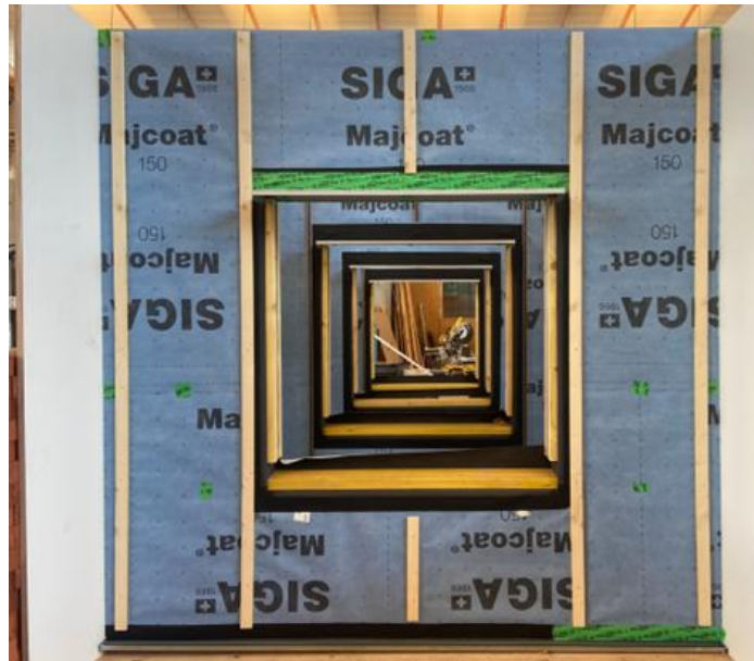
Figure 42 - Positionnement des tasseaux sur l'ossature bois
