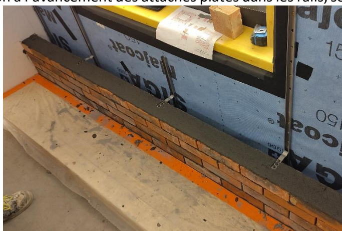
Figure 41 - Positionnement des attaches plates dans les rails selon le calepinage défini
