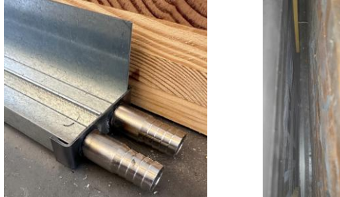
Figure 94 - Double goulotte en pied de mur dans la lame d'air
