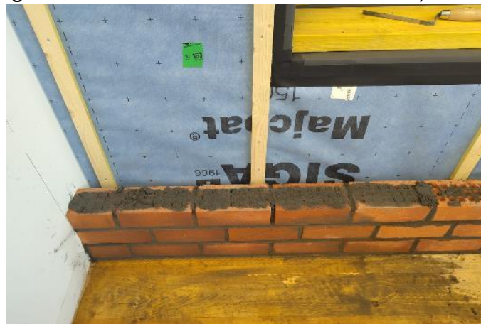
Figure 43 - Montage du mur maçonné
