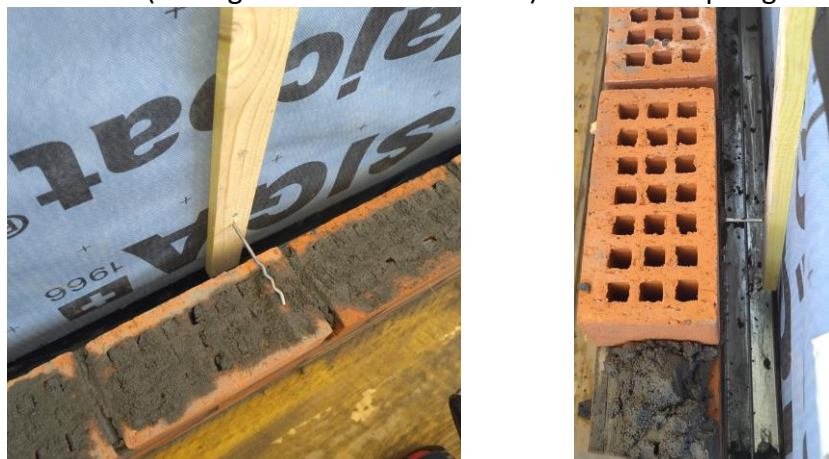
Figure 44 - Vissage des attaches filaires dans les tasseaux selon le calepinage défini
