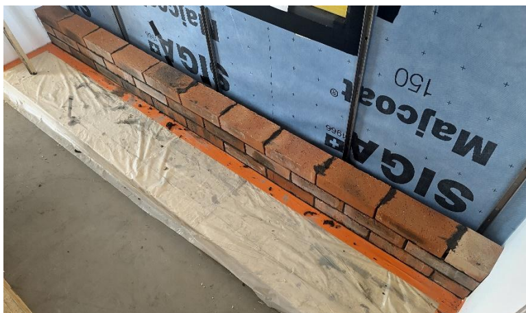
Figure 40 - Montage du mur maçonné
