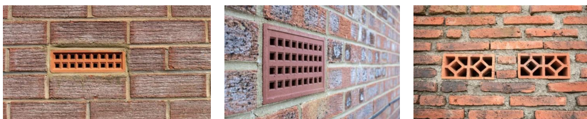
Figure 24 : Exemple de procédé avec briques perforées pour assurer un débit d'air suffisant [Images de Shutterstock]
