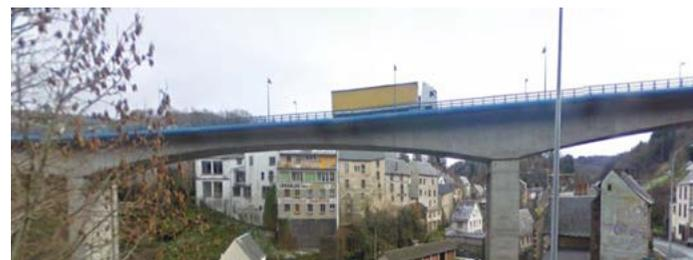
Exemple de pont caisson en béton précontraint à Rochefort-Montagne (construction 1972)..
