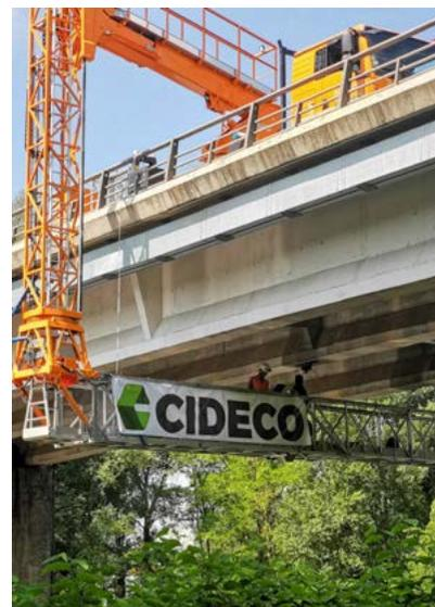
Installation des capteurs sous les poutres de pont.
