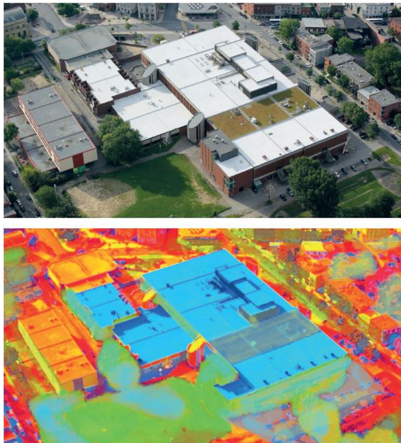
Figure 8 - Thermographie infrarouge d'une toiture avec un revêtement d'étanchéité « cool roof » (Figure SOPREMA)
